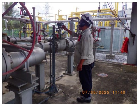
รูปที่ 2.5 สถานีวัดและควบคุมแรงดันก๊าซ (MRS)
